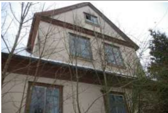
Darbnīcas ēka ar kadastra apzīmējumu 1700 033 0139 001
