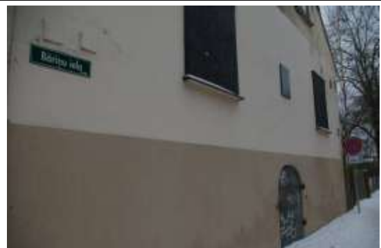
Darbnīcas ēka ar kadastra apzīmējumu 1700 033 0139 001
