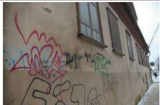
Darbnīcas ēka ar kadastra apzīmējumu 1700 033 0139 001
