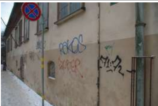
Darbnīcas ēka ar kadastra apzīmējumu 1700 033 0139 001
