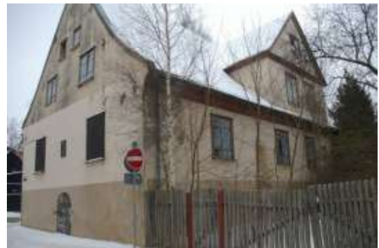
Darbnīcas ēka ar kadastra apzīmējumu 1700 033 0139 001
