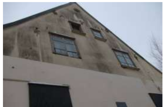
Darbnīcas ēka ar kadastra apzīmējumu 1700 033 0139 001
