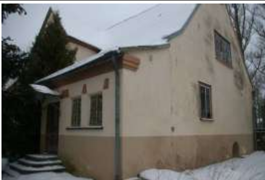
Darbnīcas ēka ar kadastra apzīmējumu 1700 033 0139 001
