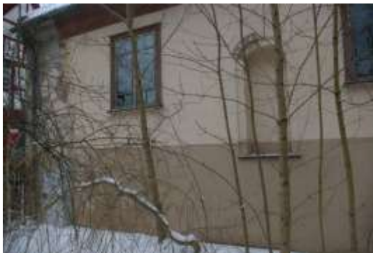
Darbnīcas ēka ar kadastra apzīmējumu 1700 033 0139 001
