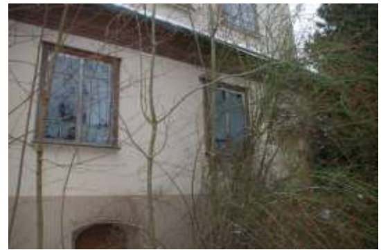
Darbnīcas ēka ar kadastra apzīmējumu 1700 033 0139 001
