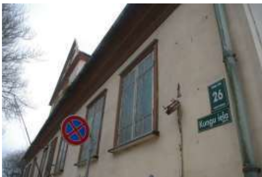
Darbnīcas ēka ar kadastra apzīmējumu 1700 033 0139 001
