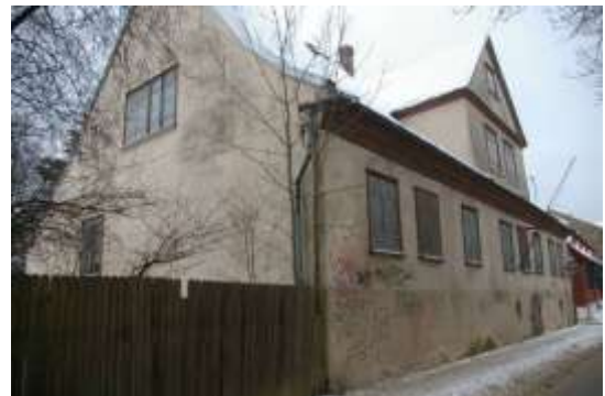
Darbnīcas ēka ar kadastra apzīmējumu 1700 033 0139 001
