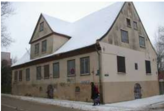
Darbnīcas ēka ar kadastra apzīmējumu 1700 033 0139 001
